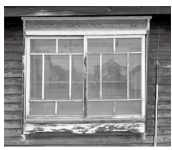
◀1 階の引き違い窓
