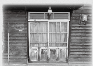
▲正面玄関の引き戸
