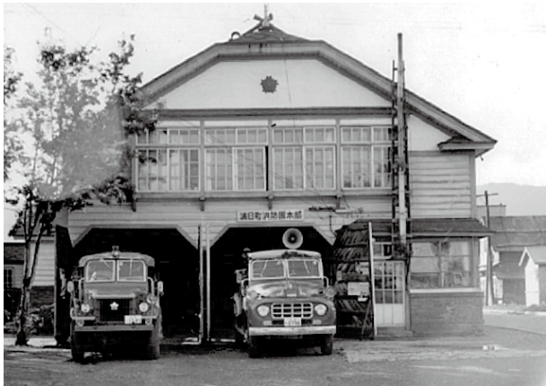
写真② 消防署庁舎（大正15年建築）
