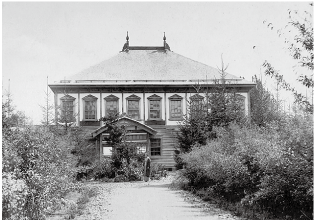
写真④ 岩村邸（明治30年代建築）
